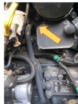
Zawór spustowy bloku tłumiącego
