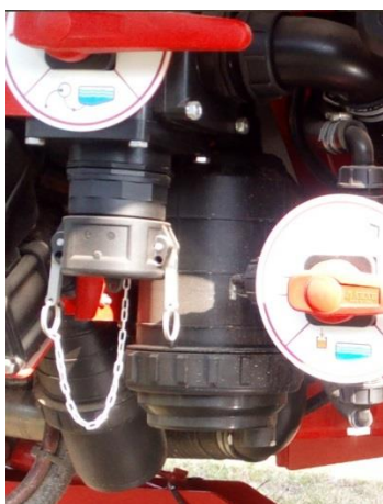
Rys. 11. Widok filtra ssawnego
